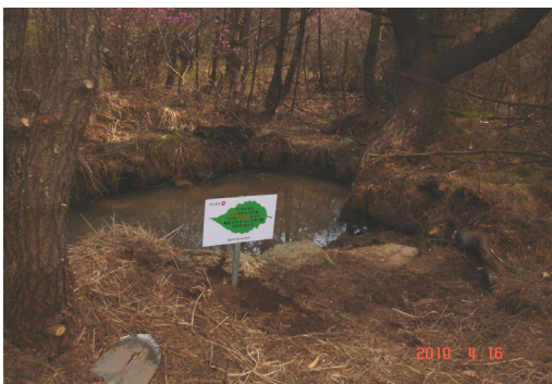
▲ 천재단 옆 저수조 축조 전경
