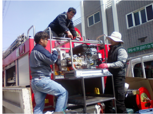
▲ 펌프 등 상부 설치
